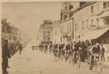
PÉTOUILLE MÊME DANS LA TRAVERSÉE DE BRETEUIL
